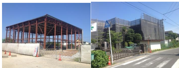
本納中学校耐震補強工事
