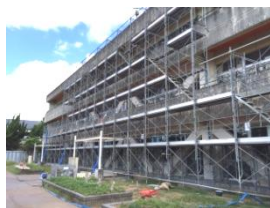
東部小学校耐震補強工事
