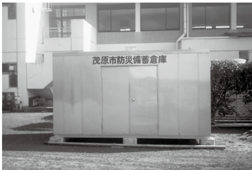
▲豊田福祉センターに設置の防災備蓄倉庫
