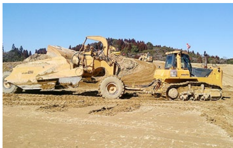
▲1台で掘削・積み込み・運搬・敷均しが可能なスクレーパによる作業（1度に10tダンプ4台分の土を運搬）。
