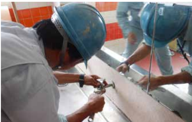
▲蛇口内に取り付けるだけで水量を減らすことができます
