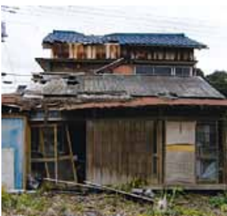
▲空き家は倒壊の恐れがあります
