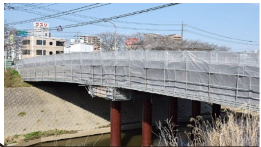
◀修繕工事中の明光橋(八千代)
