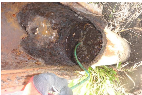
支柱内部の腐食
