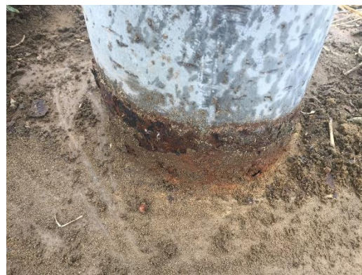
支柱基部の腐食
