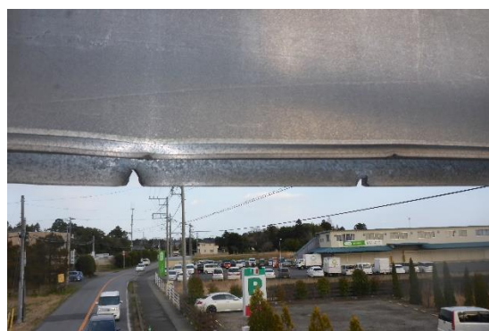
標識板のき裂
