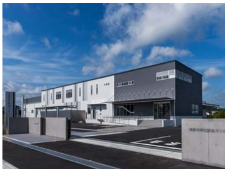
▶給食センター外観
