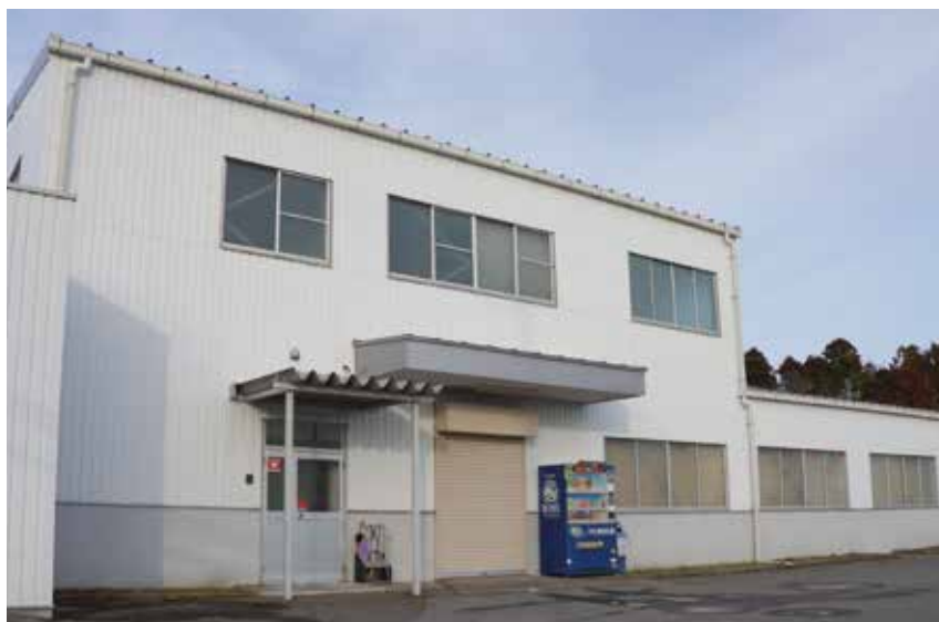
茂原工場外観
