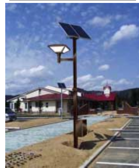
街灯への太陽光発電の設置 蓄電池併設による自立型システム
