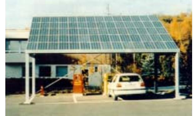
駐車場設備への太陽光発電の導入 （クリーンエネルギー自動車優先駐車場） 防災用電源、電気自動車充電用電源としても機能
