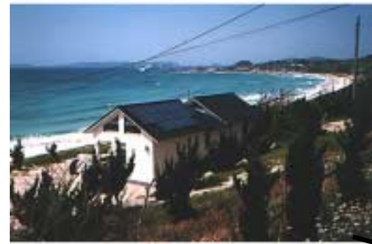
トイレ屋根への太陽光発電の設置 トイレ内照明等に利用
