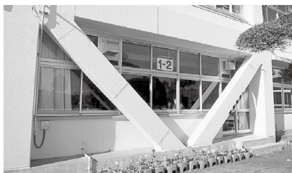
▲耐震工事が完了した東郷小学校
