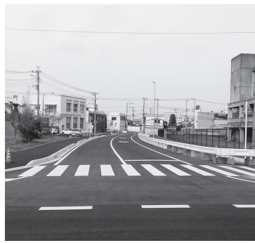
▲完成した高師町下井戸線
