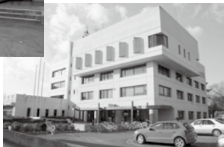
▲老朽化が進む公共施設
