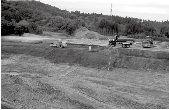
大型ダンパーやブルドーザーなどの重機による盛土工事
