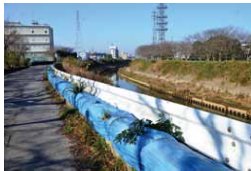
▲土のうによるかさ上げ
