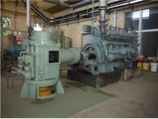
写真 雨水ポンプ原動機及び減速機
