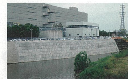
施工後（5分勾配）
