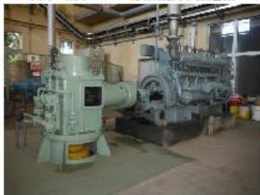
写真 雨水ポンプ原動機及び減速機
