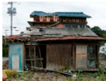
▲管理されていない空家
