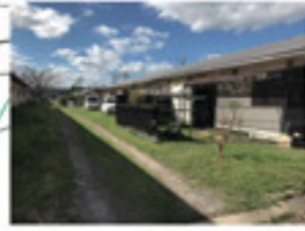
平屋長屋住宅 計20棟 84戸 現在は21世帯が居住
