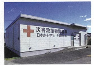
災害救援物資保管倉庫
