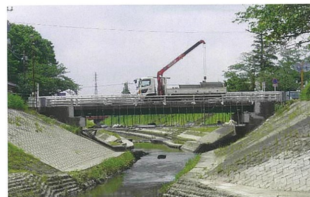
昌平橋の修繕工事の様子
