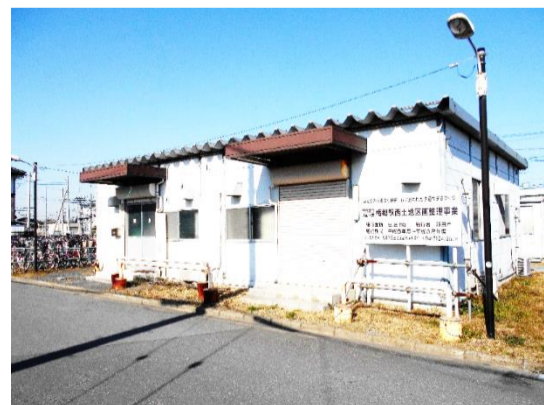
仮設店舗として利用されていた建物 (現在は区画整理事務所として活用)
