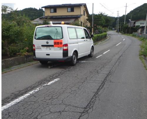
写真-2.6.1 FWD 調査状況
