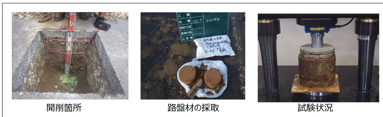
写真-2.6.2 開削調査の状況
