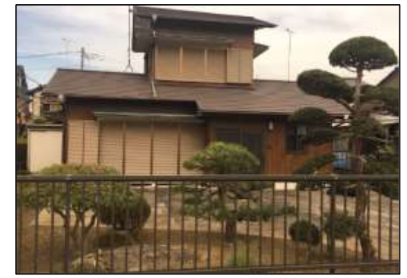
◎良 建物劣化 小有 敷地管理
