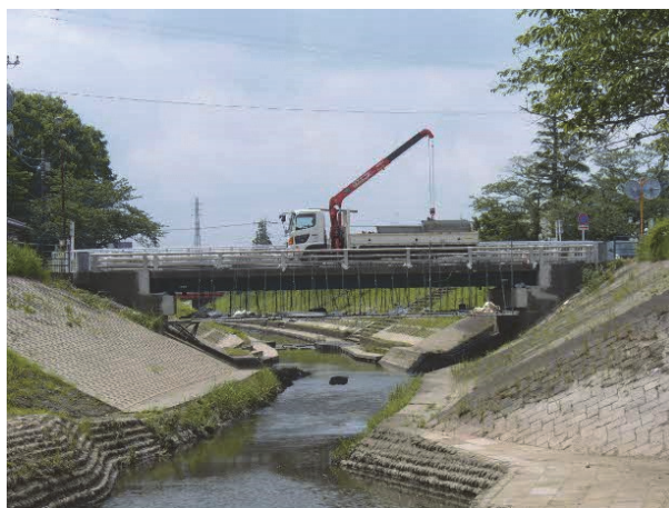
▶ 昌平橋の修繕工事の様子
