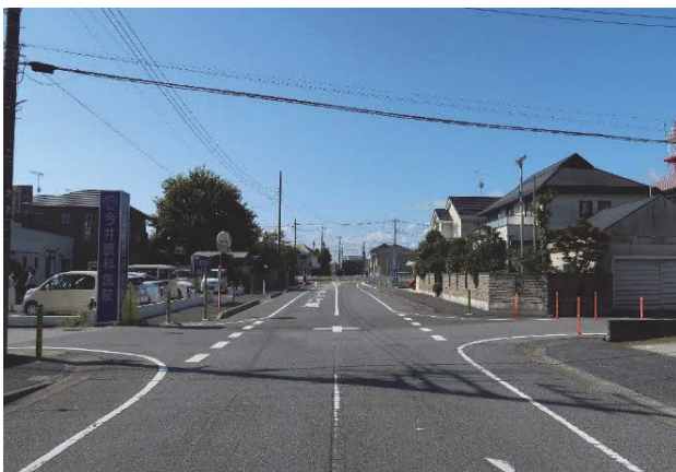
▶整備中の都市計画道路 高師町下井戸線
