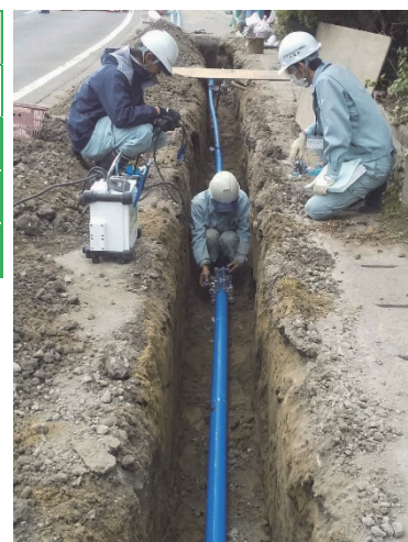
▶老朽管更新工事
