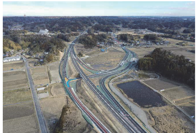
▶令和2年に開通した 茂原・長柄スマートインターチェンジ
