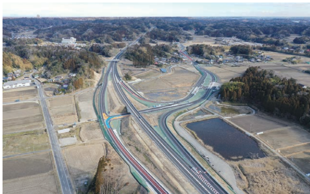
令和2年に開通した茂原・長柄スマートインターチェンジ
