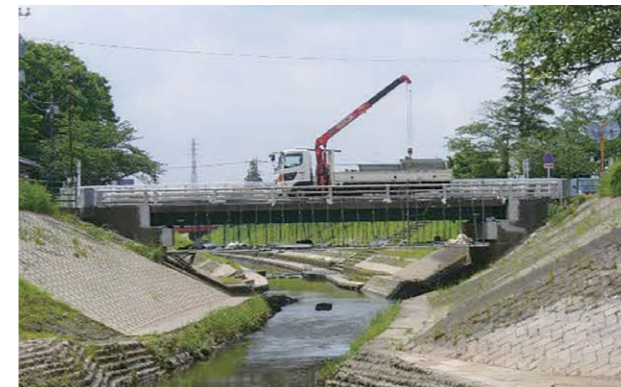
昌平橋の修繕工事の様子
