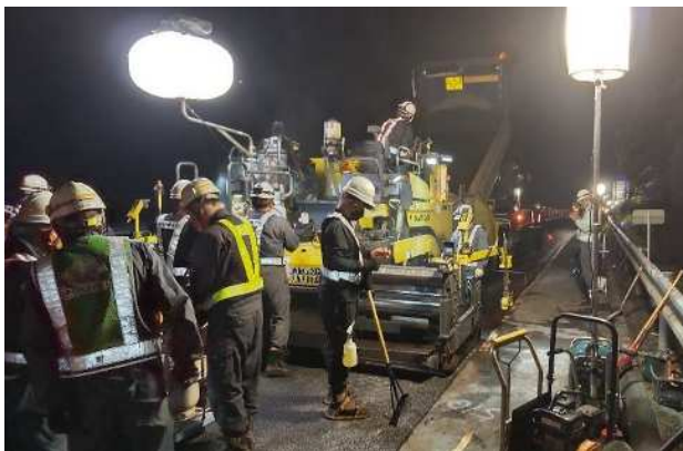
舗装補修工事
