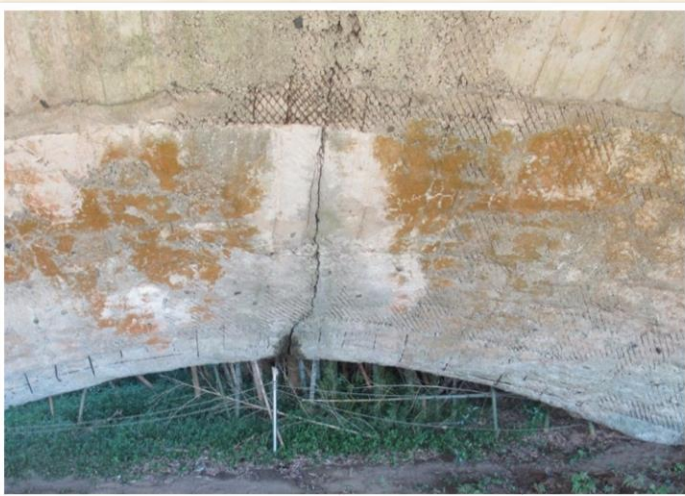
📍 壕の内部には、施工に用いられた鉄鋼や石が所々露出しています。
