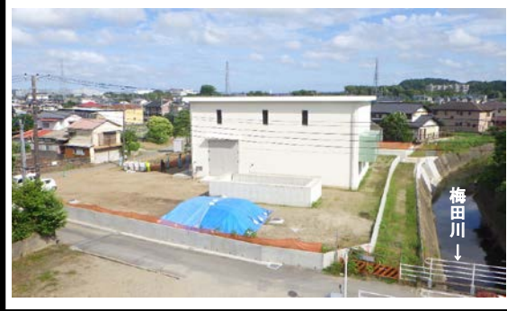
早野排水機場
