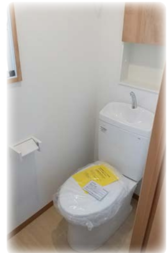
▲トイレ入れ替え
