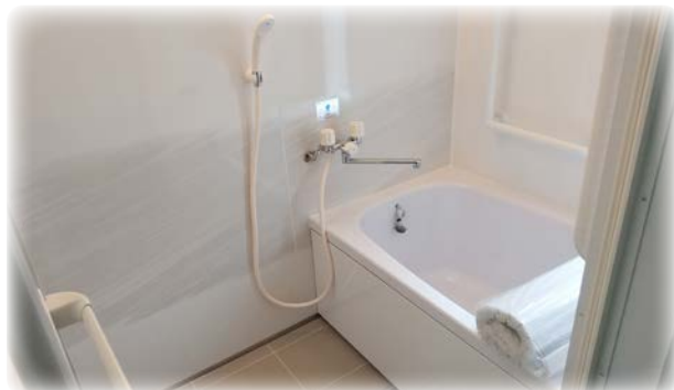
▲浴槽入れ替え（三点給湯導入）
