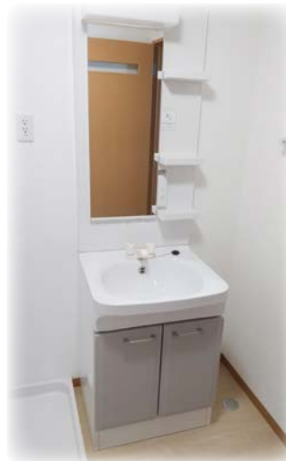
▲洗面化粧台設置
