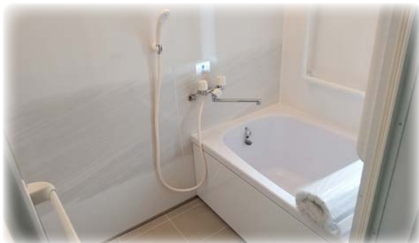
▲浴槽入れ替え（三点給湯導入）
