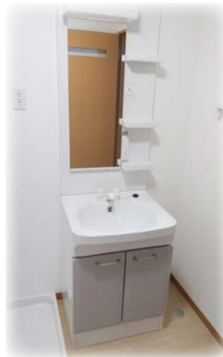
▲洗面化粧台設置
