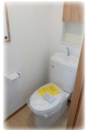
▲トイレ入れ替え
