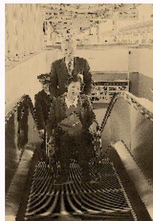
平成12年に設置されたJR茂原駅のエスカレーター
