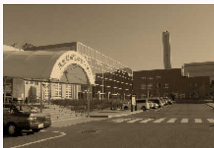
平成11年に完成した長生クリーンパーク
