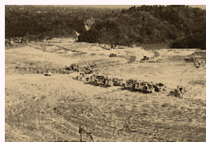
昭和62年頃の工業団地造成
