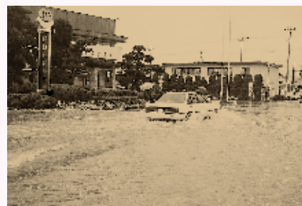
平成元年7月31日の大雨による災害
