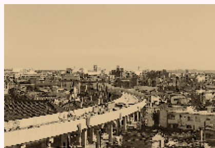
昭和54年、茂原駅を中心に 約3.3kmの鉄道高架事業が始まる
