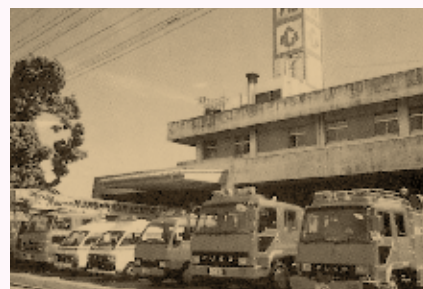
昭和46年5月に完成した消防本部・消防署庁舎
