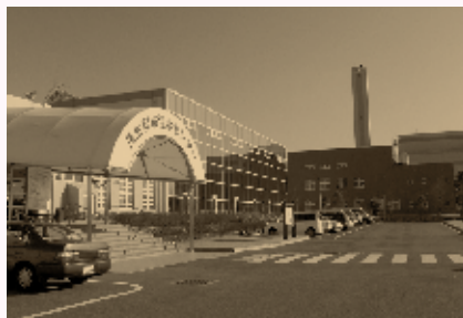
平成11年に完成した長生クリーンパーク
