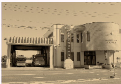
平成9年に完成した消防本部本納分遣所
