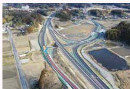
圏央道茂原長柄スマートインターチェンジ開通
