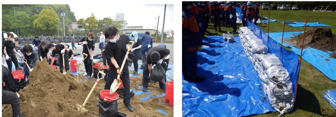
図 5-12 土のうの作成、設置イメージ
