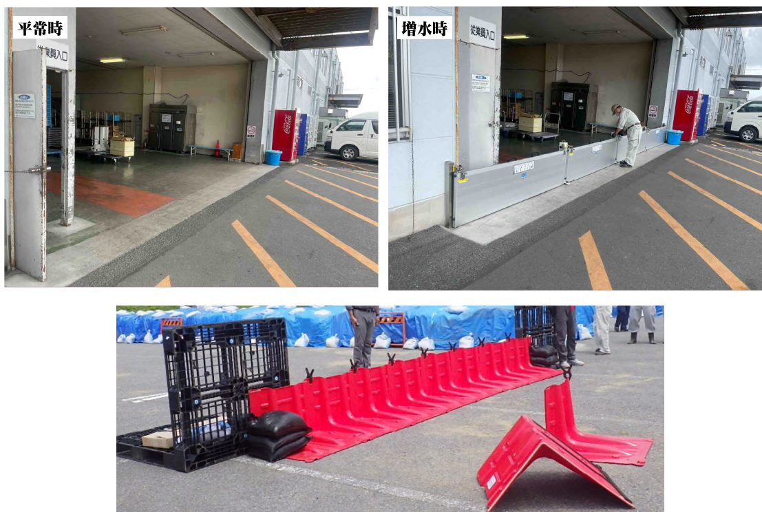
図 5-11 止水板の設置イメージ（千葉県資料より）
