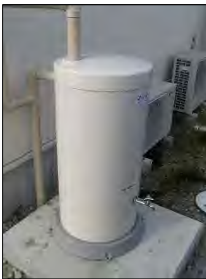
図 5-8 貯留施設の設置イメージ（千葉県資料より）
