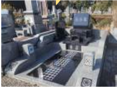
新規墓石・外柵工事
