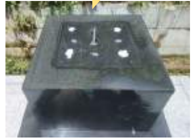
耐震補強工事
