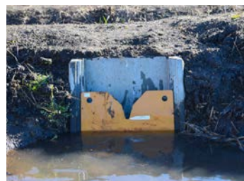
▲排水口に設置された調整板
