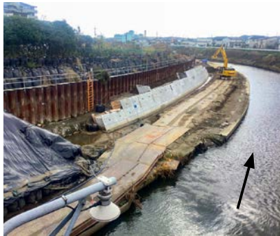
▲河川改修状況（一宮川）
