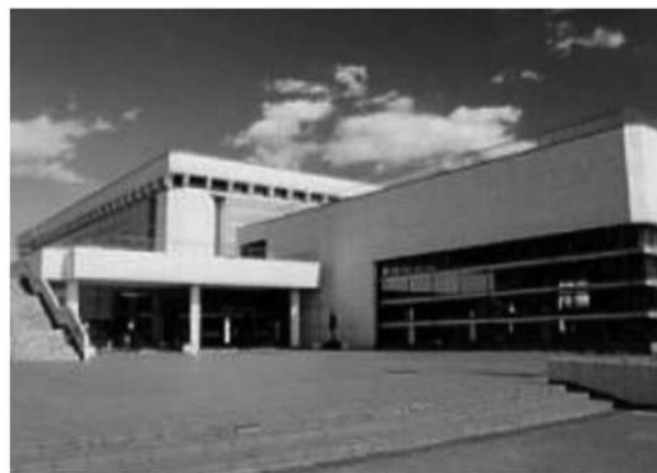
令和2年度に大規模改修工事を行った市民体育館
