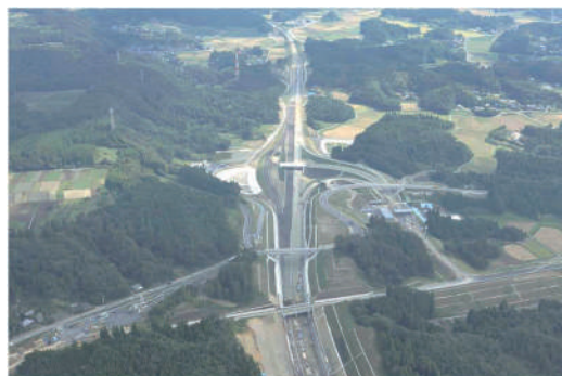
茂原北インターチェンジ
