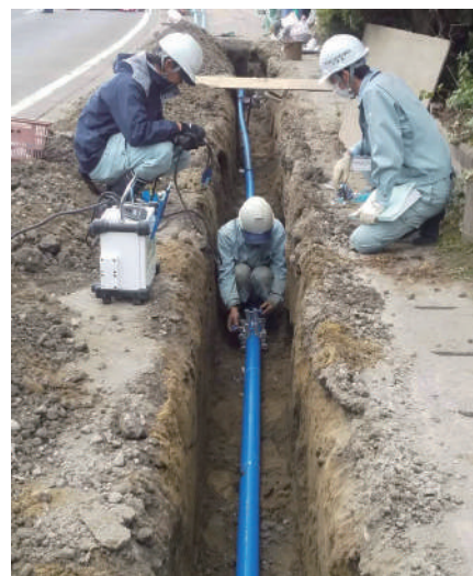
上水道老朽管更新工事
