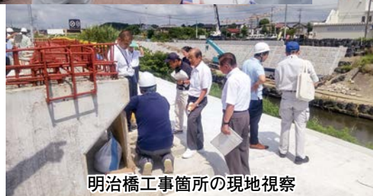
一宮川工事箇所（ほほえみ橋周辺）の現地視察
