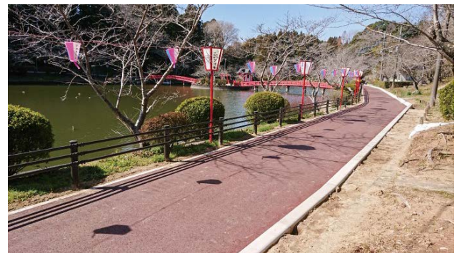
▲改修後の茂原公園園路（令和5年度）
