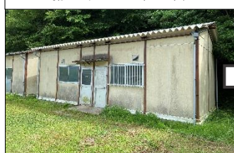
撤去した部室棟
