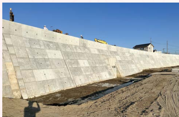
ひかん ▲樋管拡大工事
