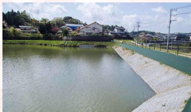
▲更新工事後のため池
