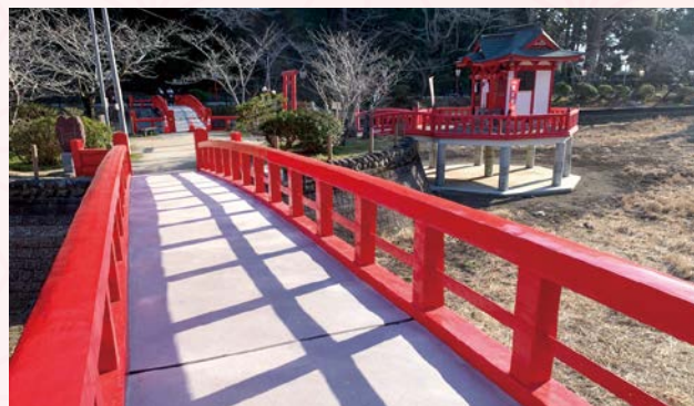
▲改修された茂原公園の弁天橋（令和6年度）
