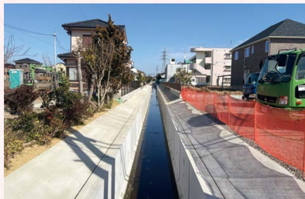
▲東茂原地区排水整備工事
