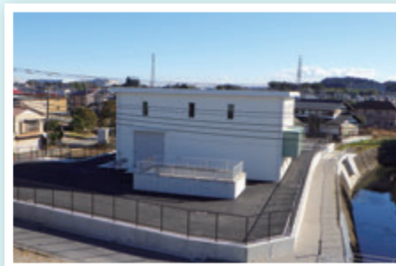
▲排水機場の整備
